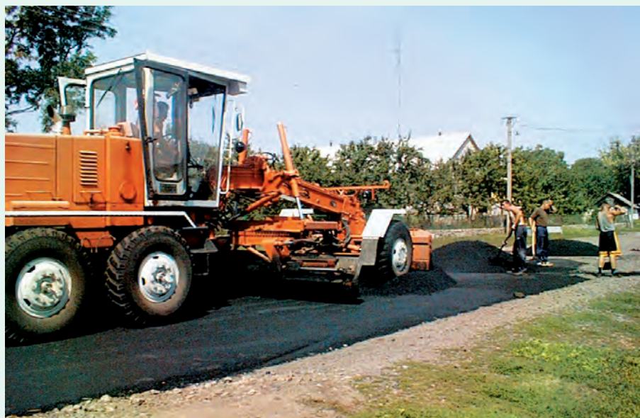
Ремонт дороги в с. Старкуватому
