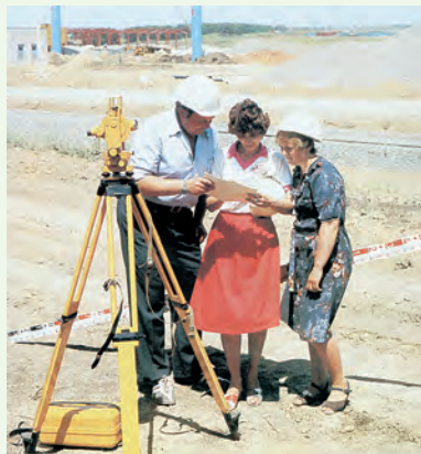
Так починалося будівництво комбінату
